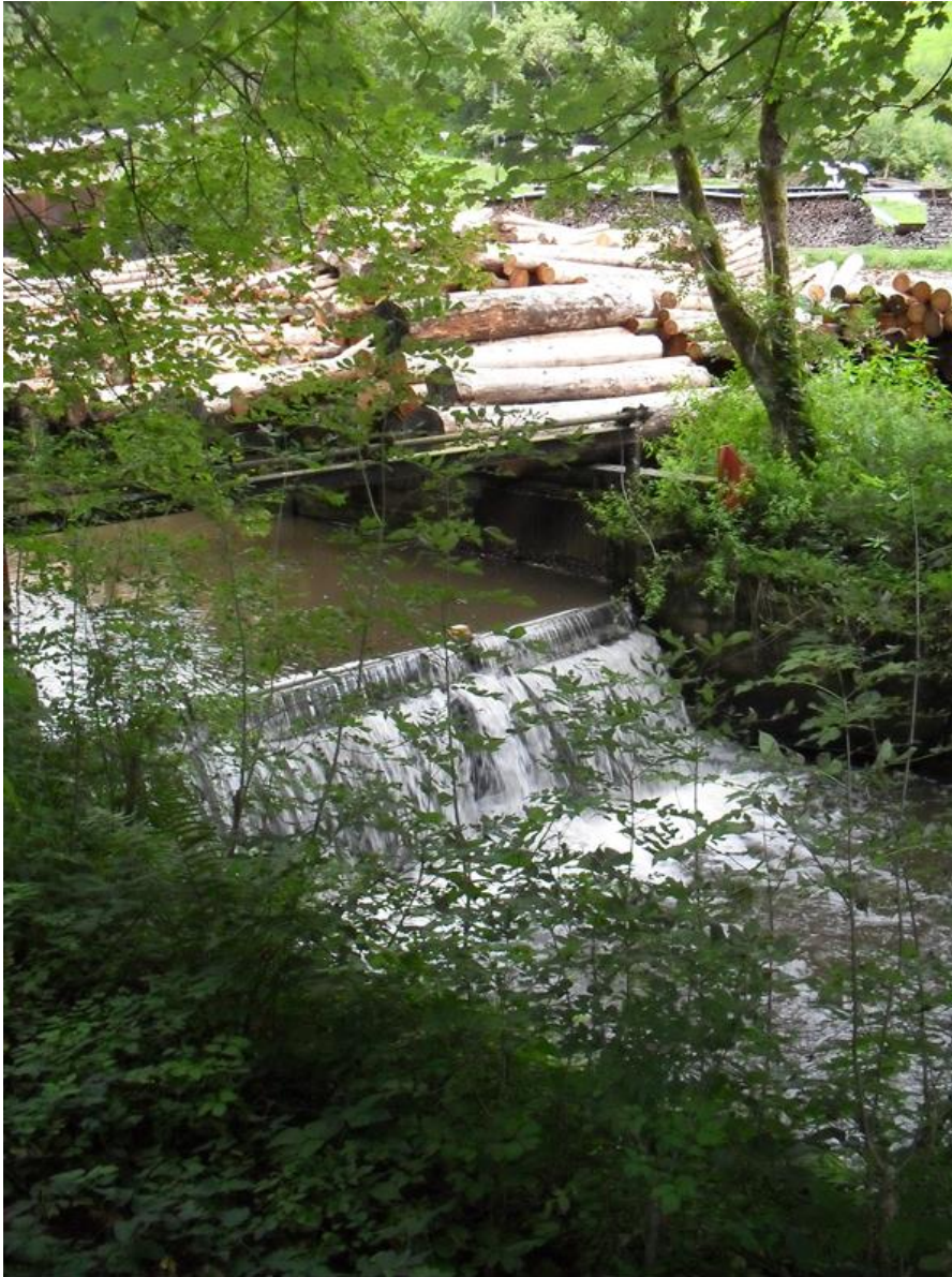
Rösersmühle, Mainhardt, Wehr, Einlass zur Turbine (Rechen), Holzlagerplatz, August 2010
