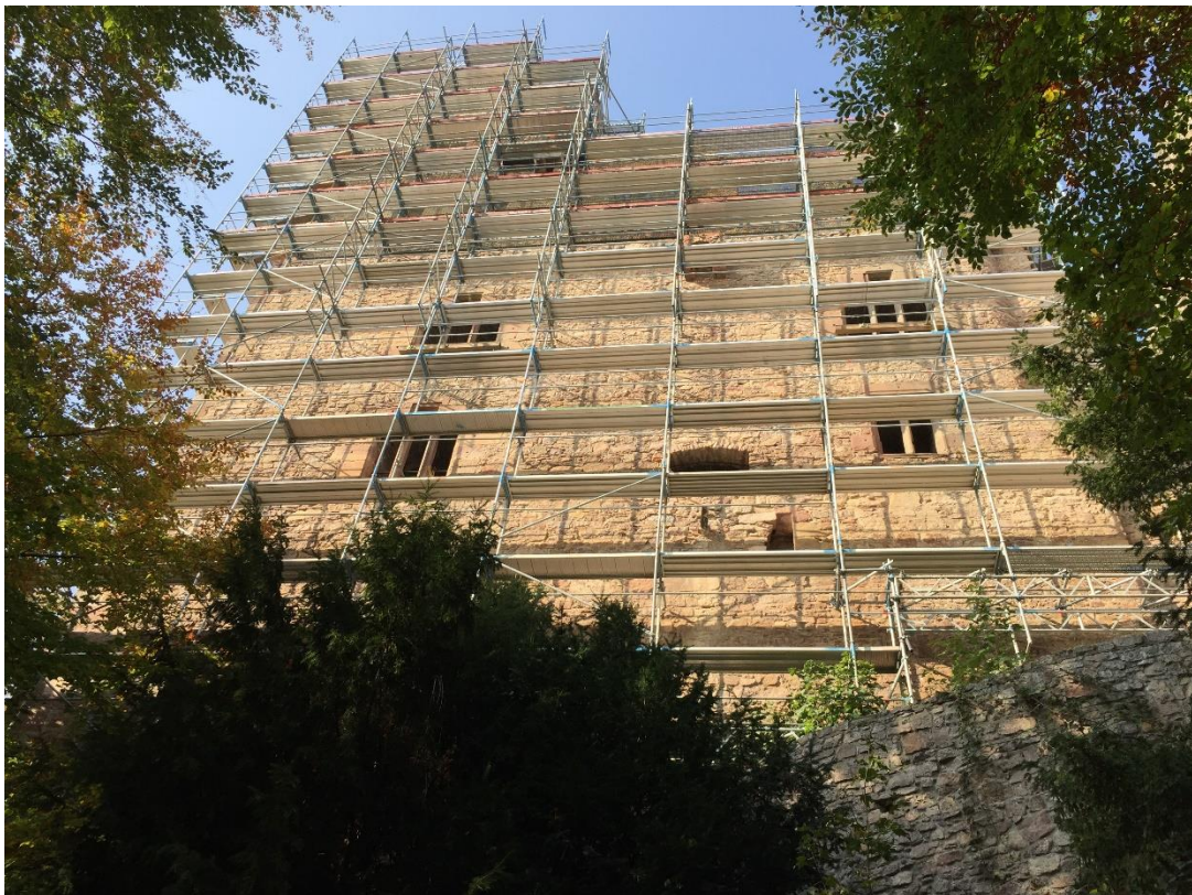
Abbildung 9 Eingerüsteter Bernhardsbau des unteren Burghofs. Fotos: Alexandra Ziegeler.
