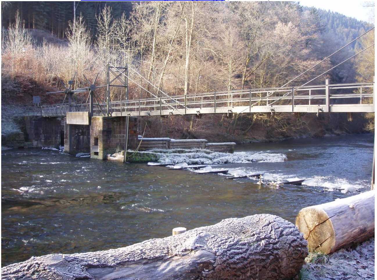
Abbildung 12 Wasserstube Nonnenwag in der Nagold, 19. Jh. Gemeinfrei https://upload.wikimedia.org/wikipedia/commons/c/c3/WasserstubeNonnenwag3.jpg (13.01.2021)
